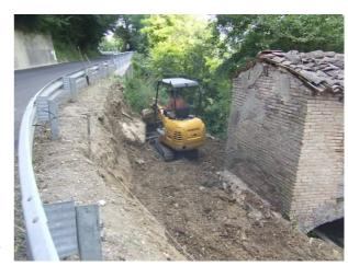
Teramo e del Cai, con la rimozione della terra addossata ad una parete, la realizzazione del muro di contenimento a monte, la canalizzazione delle acque piovane e interventi di stabilizzazione del pendio a valle.
