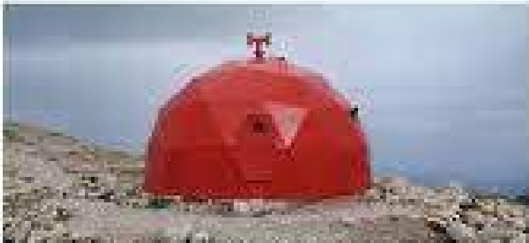
Foto del bivouac al termine dell'intervento di manutenzione
