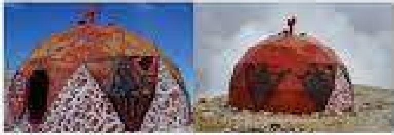
Foto del bivouac prima dell'intervento di manutenzione
